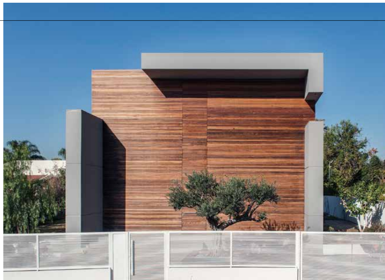
החזית הקדמית: חיפוי בסרגלי עץ איפאה בהתקנה סמויה ומסגרת בטון העוטפת את המבנה ב"קטעים". דלת הכניסה נטמעת בתוך חיפוי העץ כחלק בלתי נפרד.
